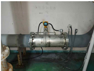
수자원공사 횡성지사 Air, 300A 막필터 교체 주기 측정용 FN질량유량계
